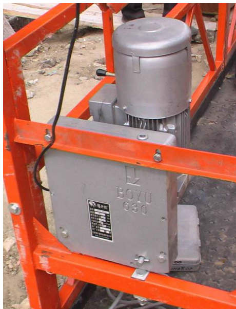
Рисунок 8 – Крепление лебедки на торцевом ограждении подъемника
